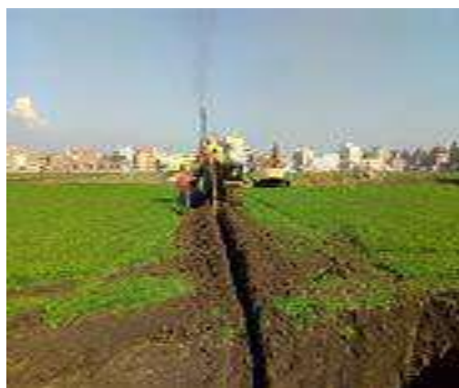
شكل (8-8 ب) : صورة أخرى لإحدى الآلات المستخدمة في عمل المصارف الحقلية
